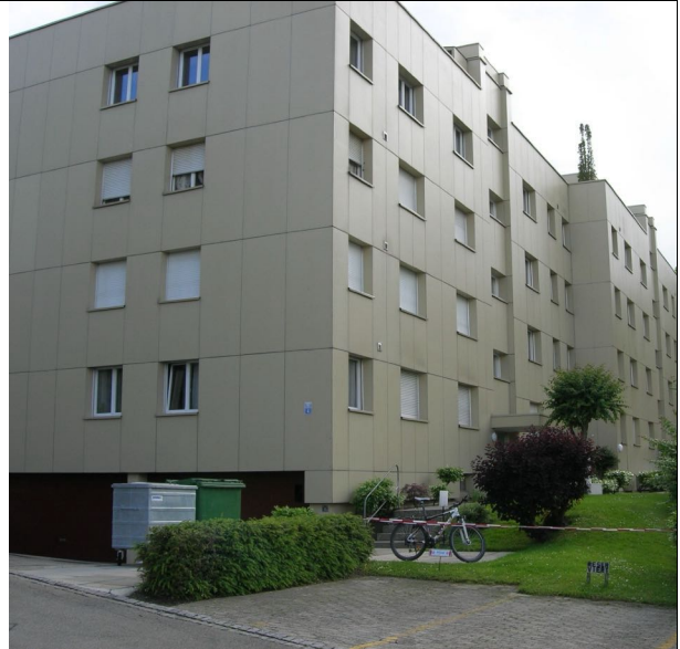
Haus Ost und Nordseite
