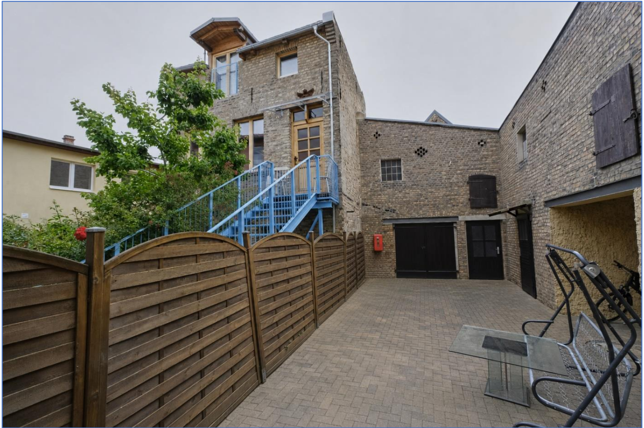
Innenhof m. PKW-Stellplatz (Sicht zum Nebengebäude u. Garage)
