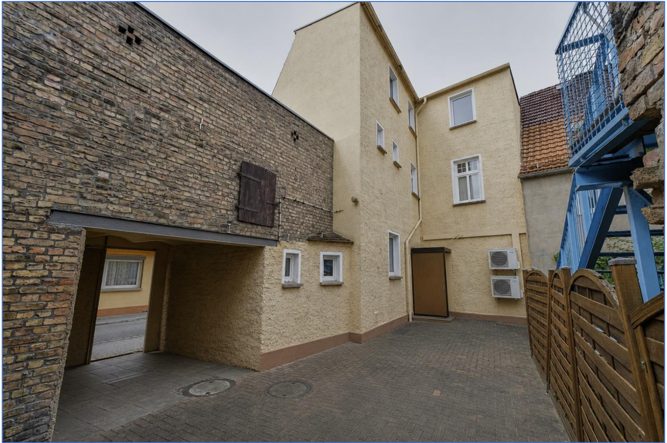
Innenhof (Sicht zum Hauptgebäude)
