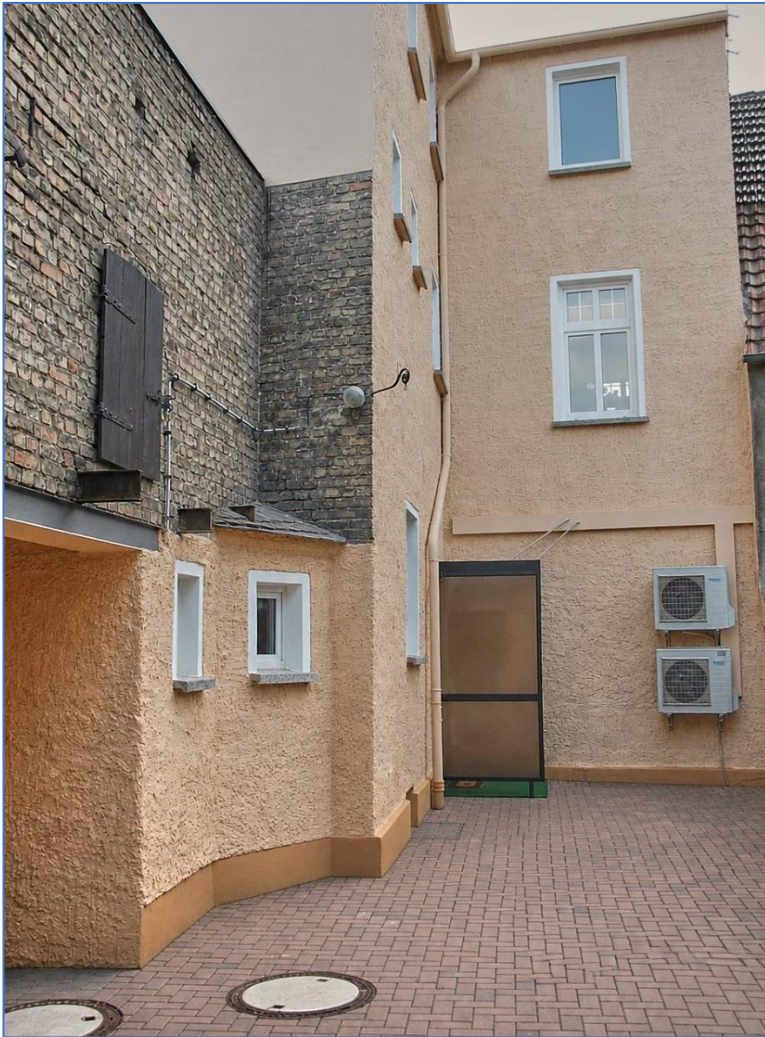
Innenhof (Sicht zum Hauptgebäude)
