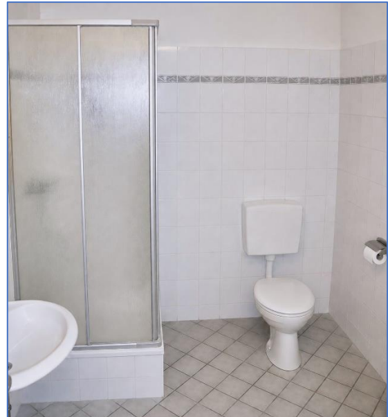
Raum OG, Bad m. Dusche, WC
