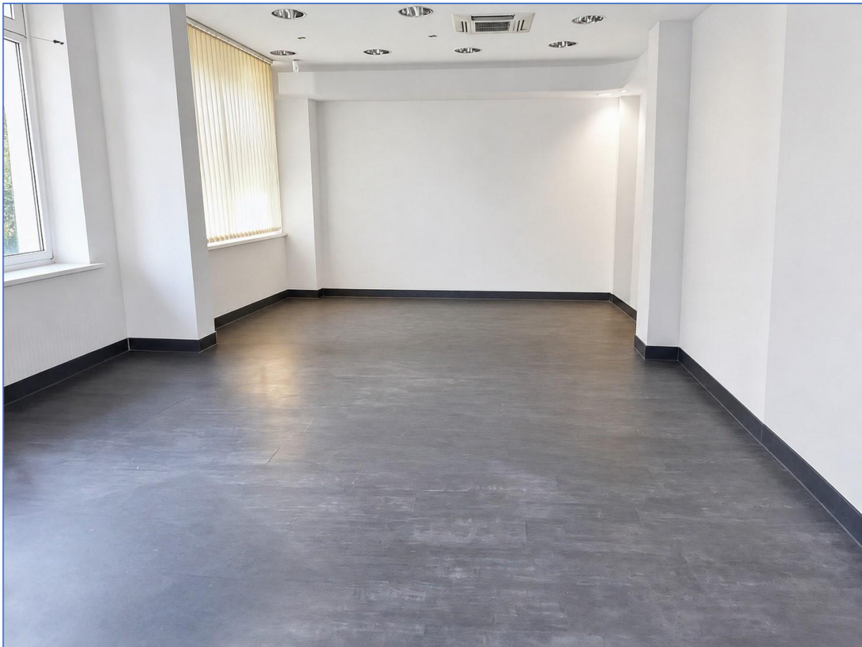
Raum EG, Verkaufsraum (entkernter Zustand)
