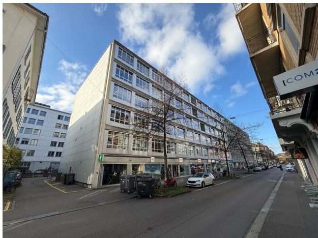
Aussenansicht der Liegenschaft
