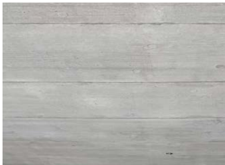
DECKE WOHNUNGEN Sichtbeton lasiert
