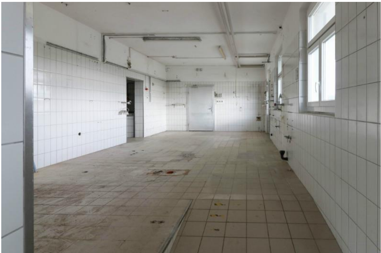
Verarbeitungsraum ehemalige Käserei, Erdgeschoss
