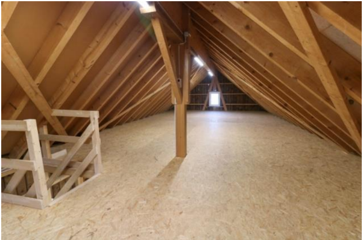
Lagerraum Schopfanbau, Dachgeschoss
