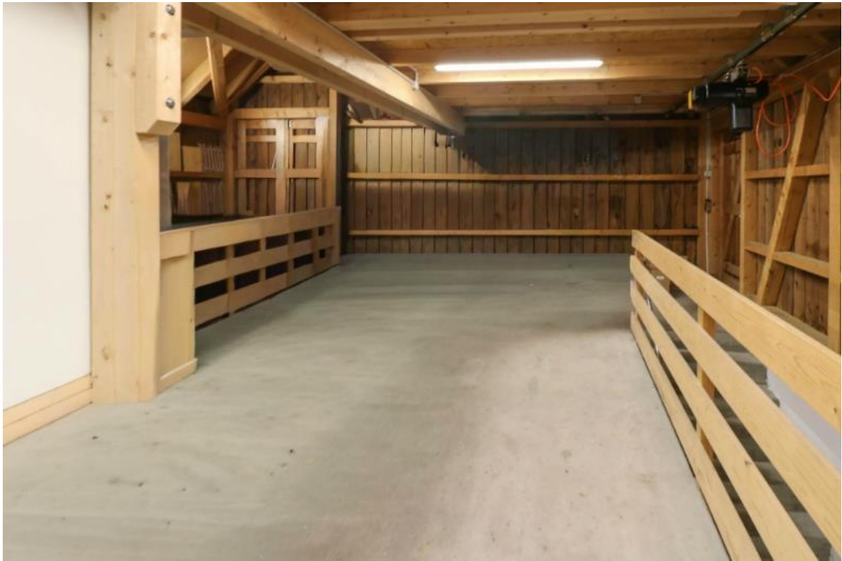
Lagerraum Schopfanbau, Obergeschoss
