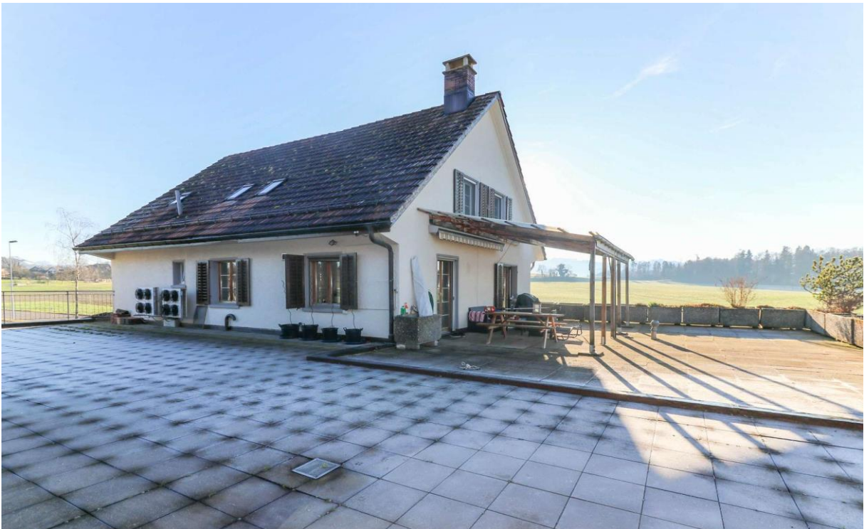
Wohnung mit grosser Terrasse, Gewerberäume im EG
