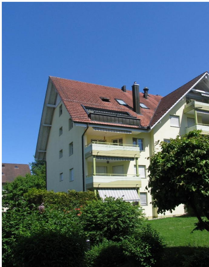
Nordwestansicht (Wohnung 1. OG)
