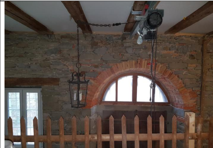
UG Mühle, Eingang. Wände sandgestrahlt
