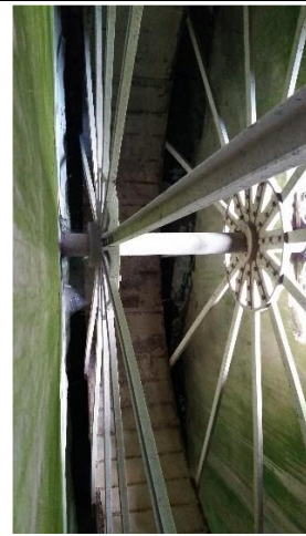
Möhlerad, 6m Durchmesser, erneuert
