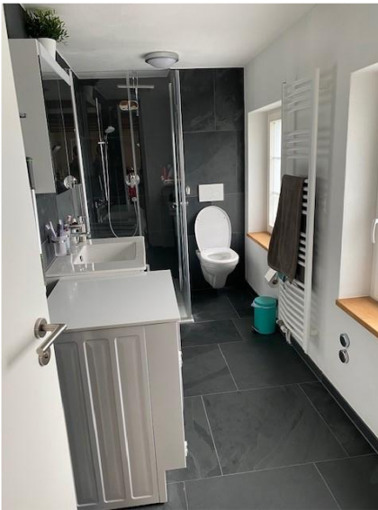
Waschtisch, Spiegelschrank, Dusche / WC, 2 Fenster
