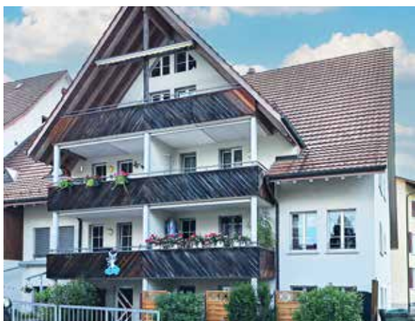
Vorderfassade mit Hauszugang
