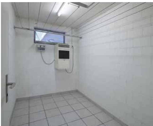
zwei Trockenräume mit Raumlufthäschetrockner
