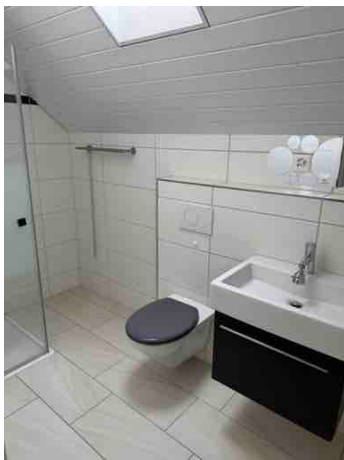
Vollausgestattetes Bad auf jedem Stockwerk.
