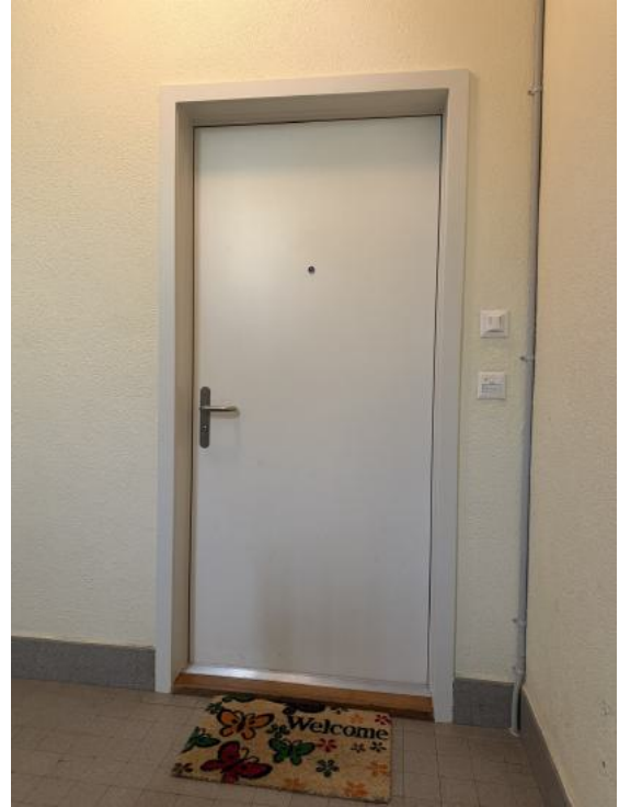
Wohnungstüre im Treppenhaus
