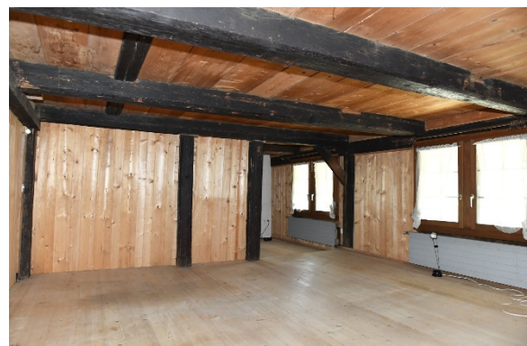
Zimmer OG, südseitig, Strassenseite
