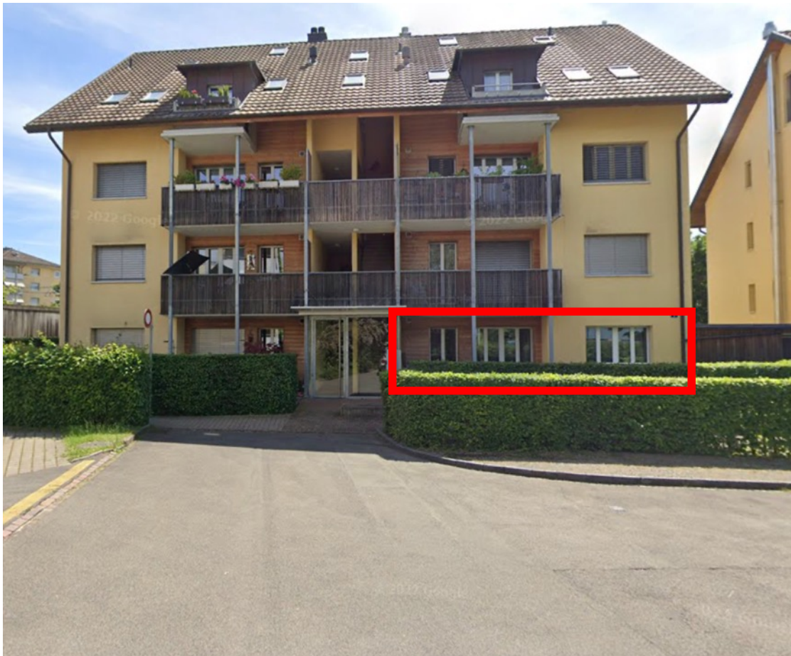
Ansicht von Norden (Hauseingang)
