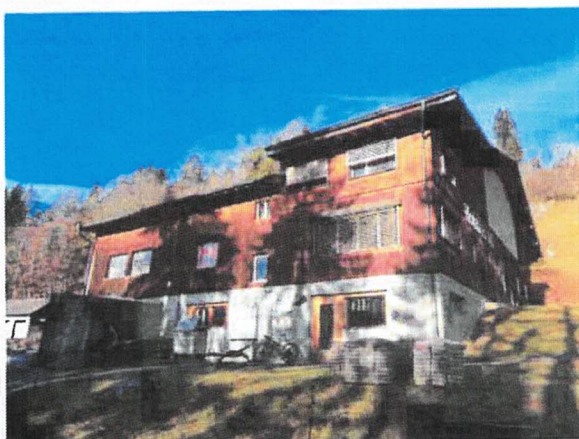
Ansicht von Süd/Osten
