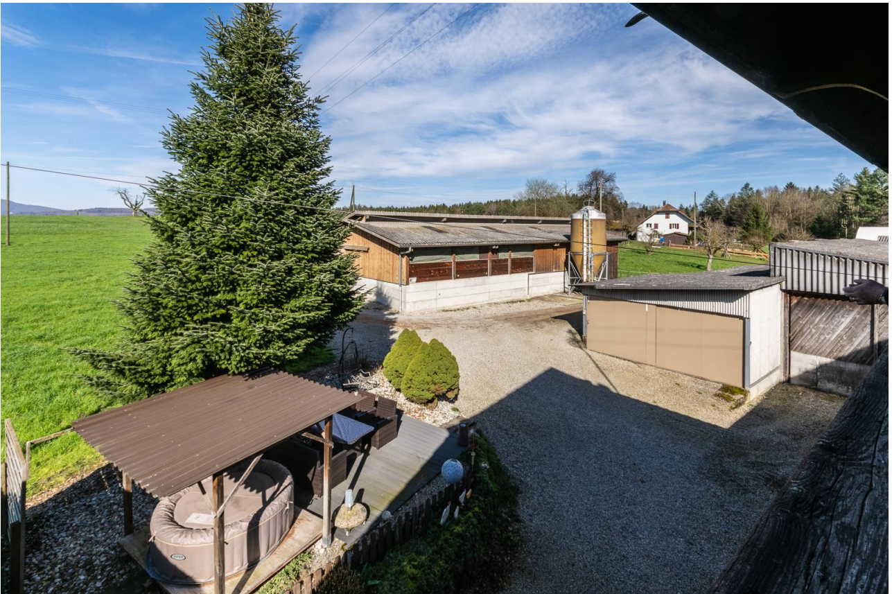
Blick vom Estrich auf Hofareal mit Tierlaufstall im Hintergrund
