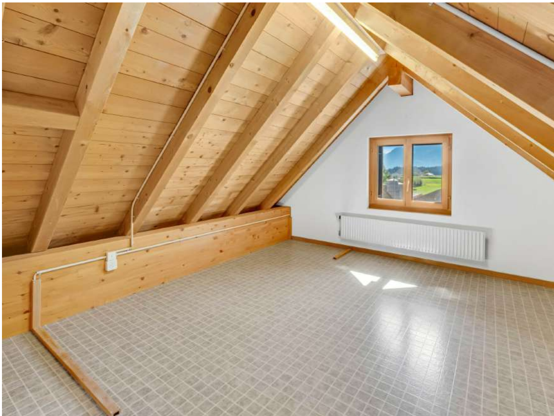
Estrich der 4.5-Zimmer- Wohnung
