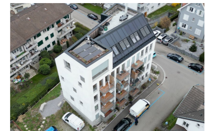
Photovoltaik- & Thermische Solaranlage
