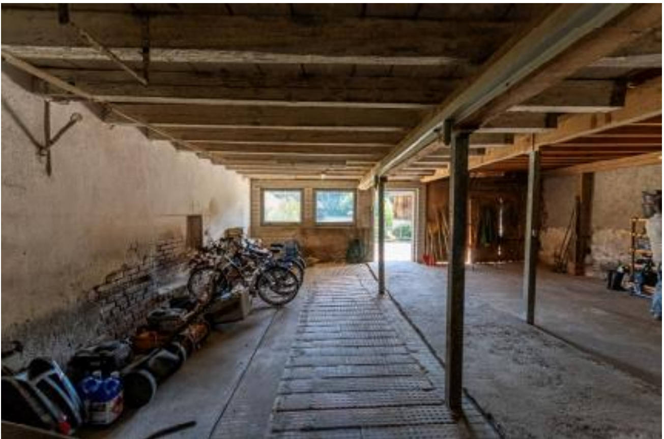
Ehemaliger Stall in Scheune Nr. 230
