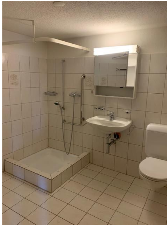
Duschen / WC EG
