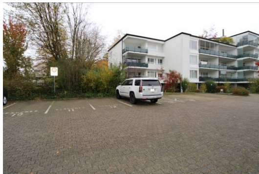
Aussenparkplätze vor der Südostfassade Ansicht 2
