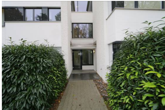
Hintereingang im EG an der Nordwestfassade
