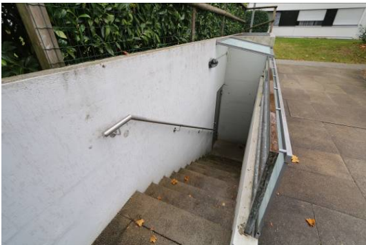
Zugang zur Tiefgarage vor der Nordwest- fassade
