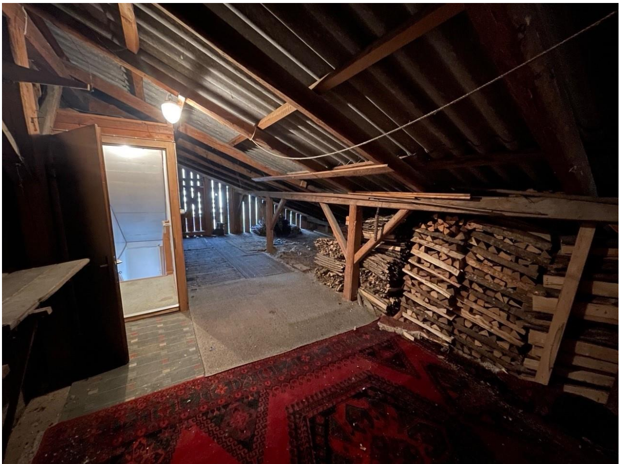
Schopfanbau innen OG
