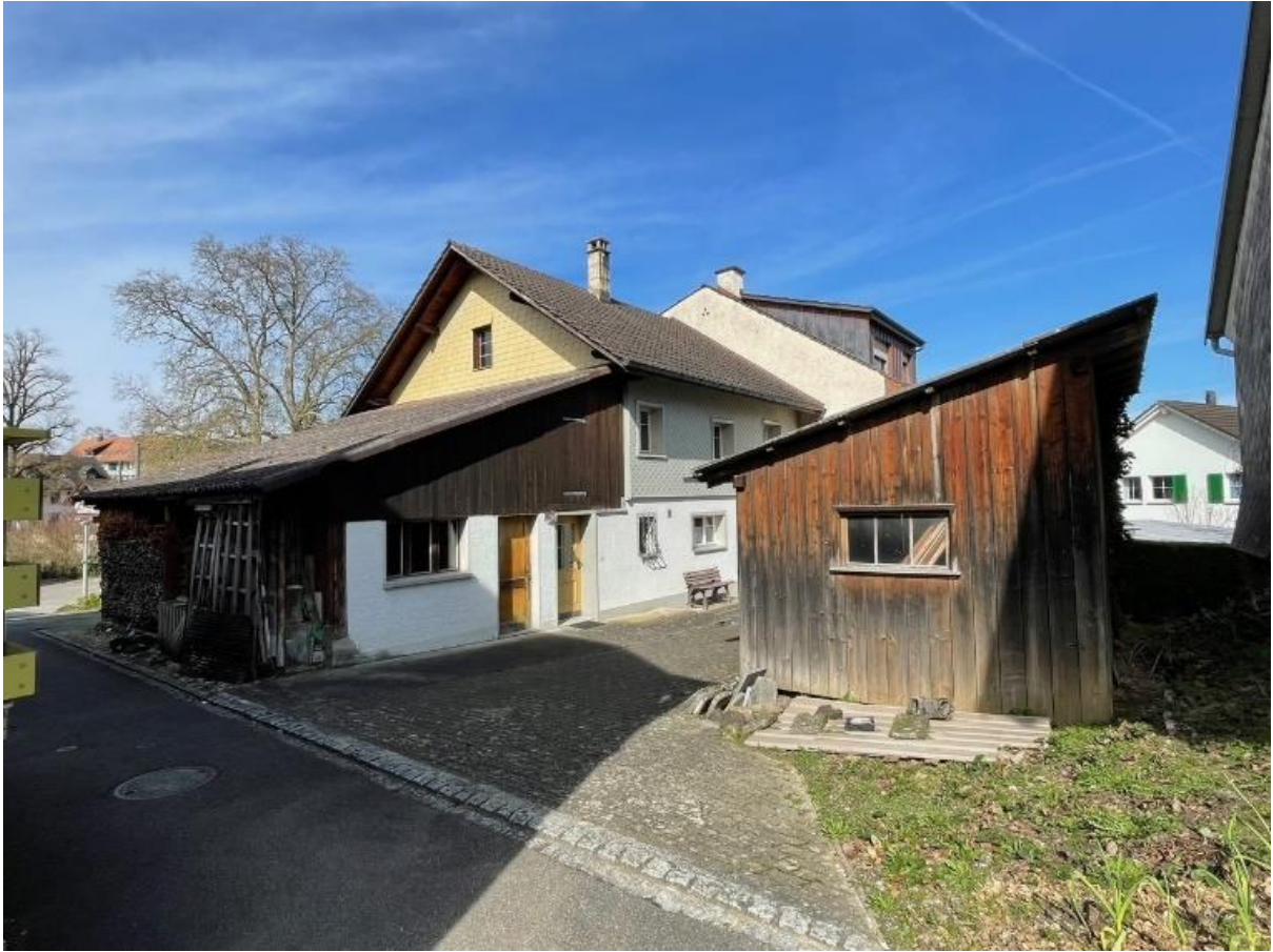
Nordostansicht mit Schopfanbau und sep. Schopf (rechts)
