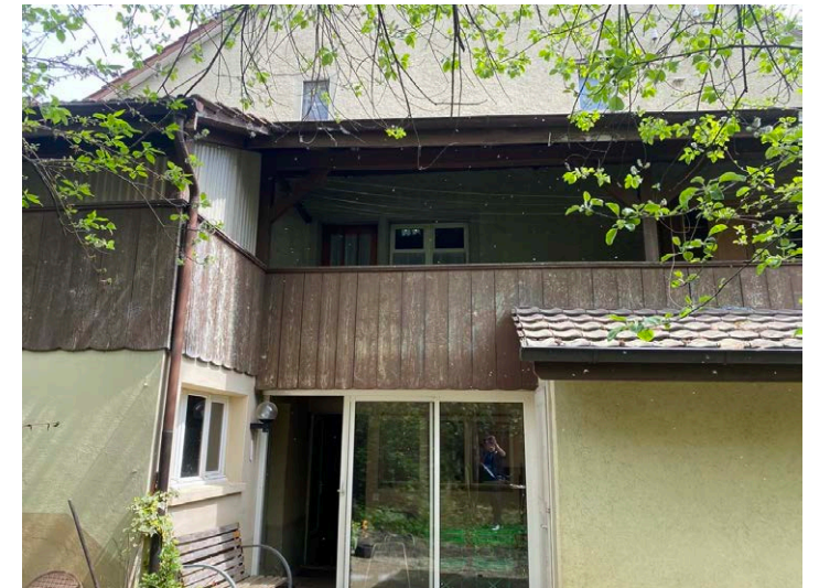
Westfassade Laube Eingang Küche mit Wintergärtli
