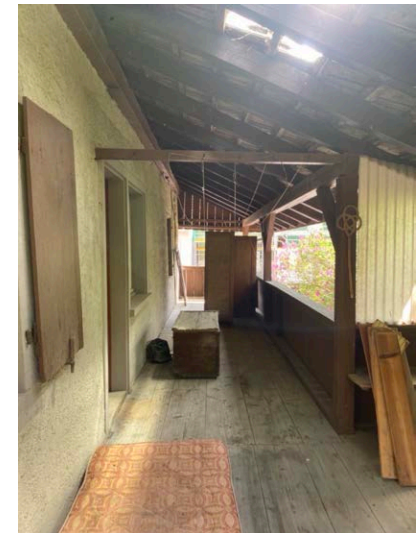
Laube Zugang von Arbeitszimmer
