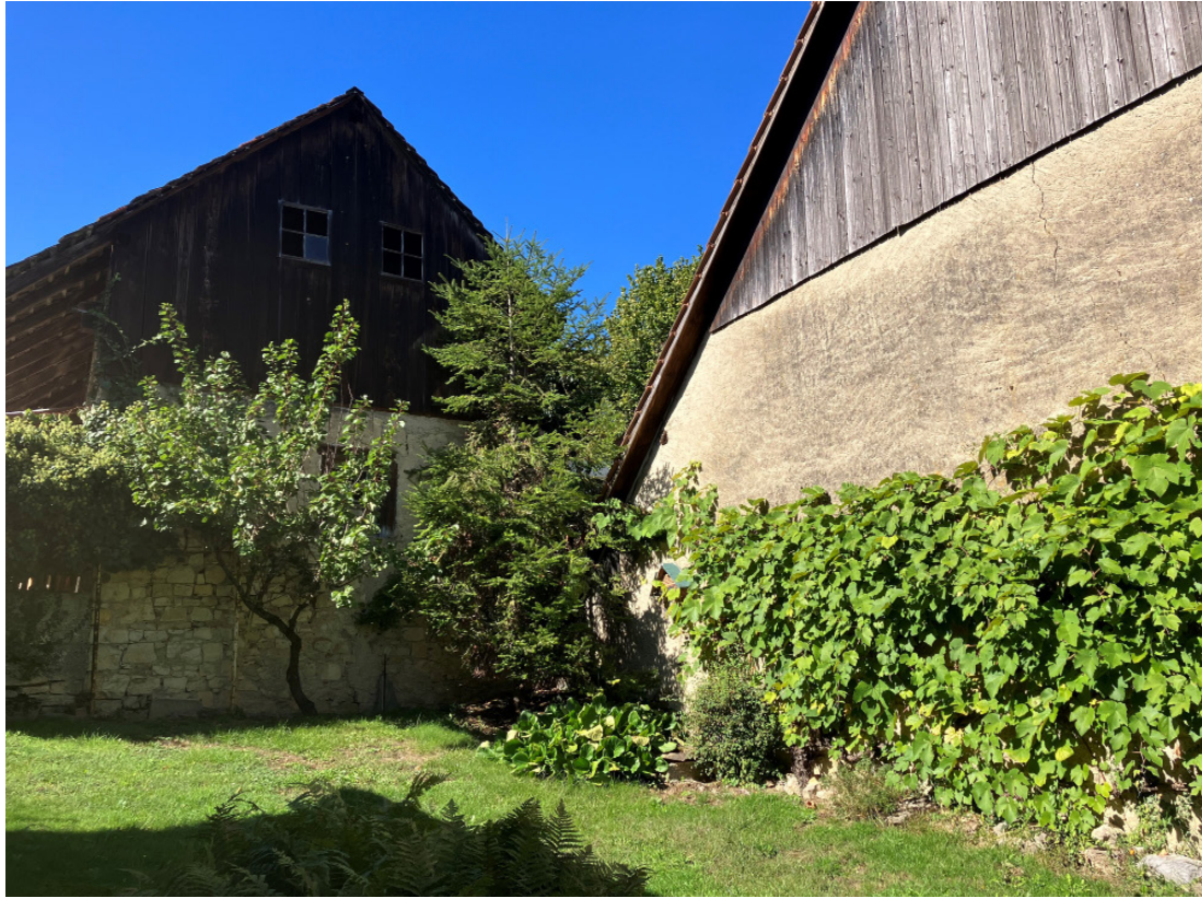
Ostfassade Speicherbau. Sockel (reine Sockelmauer) und erstes Geschoss mit Kalkbruchsteinmauerwerk, oberstes Geschoss mit Holzschalung. Hofsituation über Eck mit Scheune.
