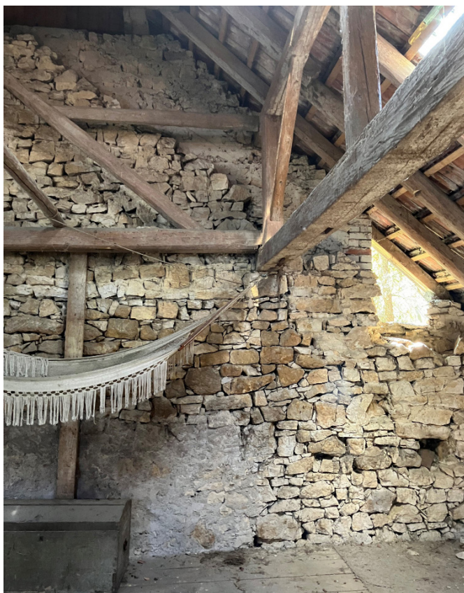
Massive Giebelwand mit Kalksteinblöcken. Gut sichtbare nachträgliche Aufstockung.
