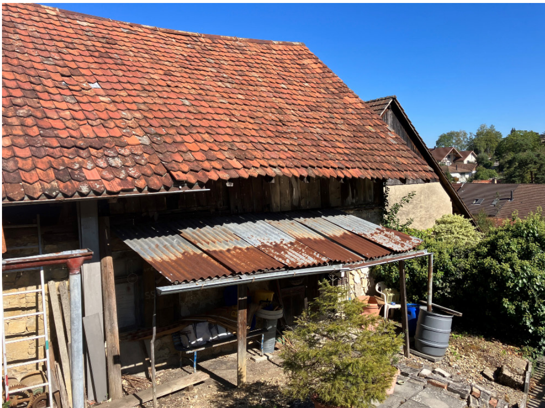
Zwischenterrasse Speicherbau. Eingang ins erste Geschoss
