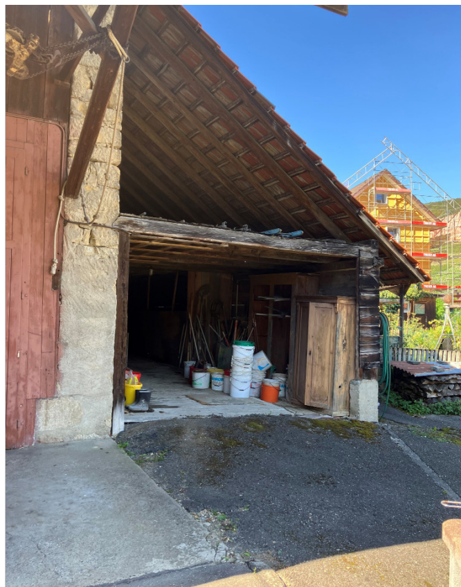
Offener seitlicher Anbau der Scheune
