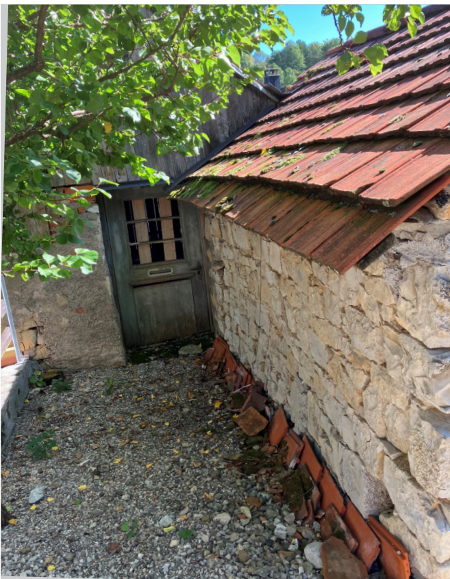
Westlicher Eingang ins Dachgeschoss des Speichers.
