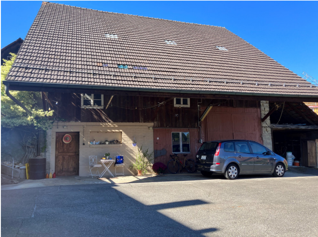
Hauptfassade Scheune mit Vorplatz
