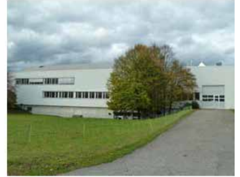
Zufahrt Mittlere Produktionshalle
