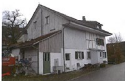
0336 Nordost- und Nordwestfassade
