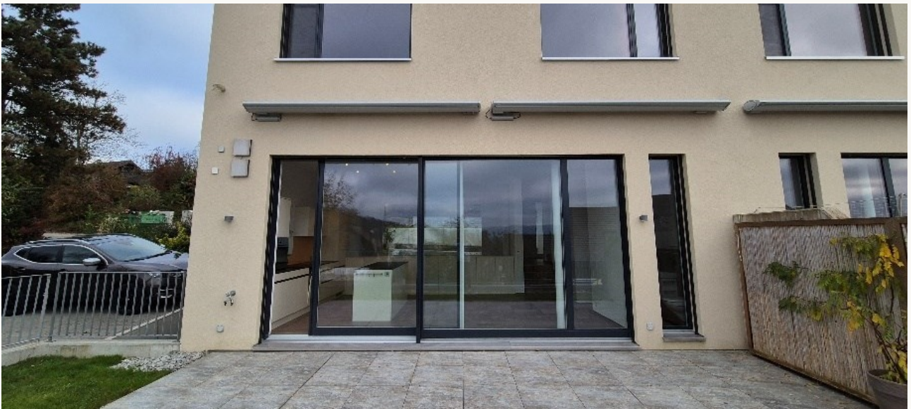
Hauptterrasse vor dem Haus mit Rasenstreifen
