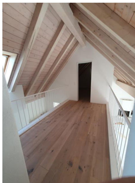
offene Galerie über Wohnen/Eingang
