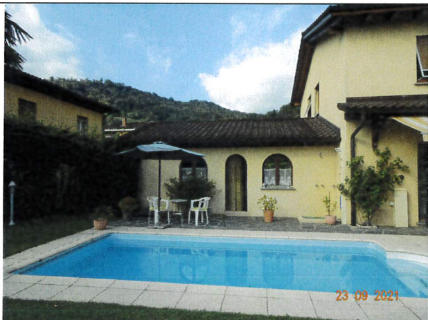
Vista parziale facciata Sud e piscina
