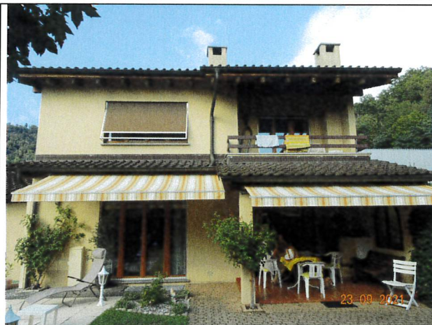
Vista parziale facciata SUD
