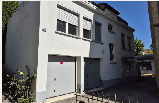
Façade, côté rue
