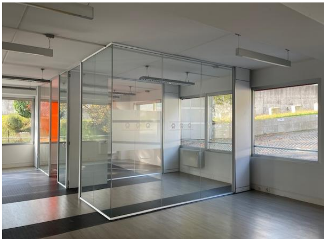
Suddivisioni degli spazi con pareti in vetro insonorizzate
