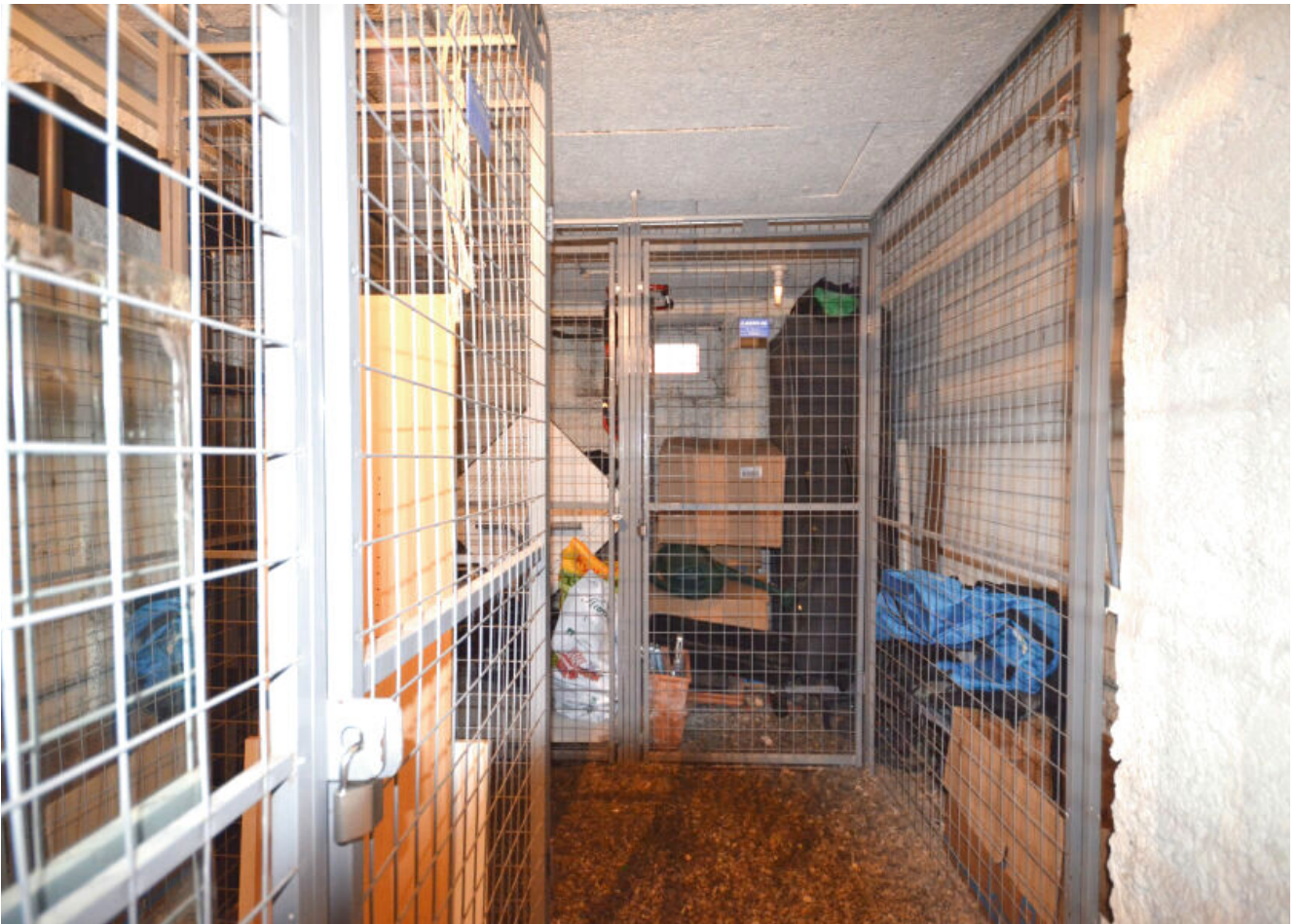
Kellerabteile im Untergeschoss.
