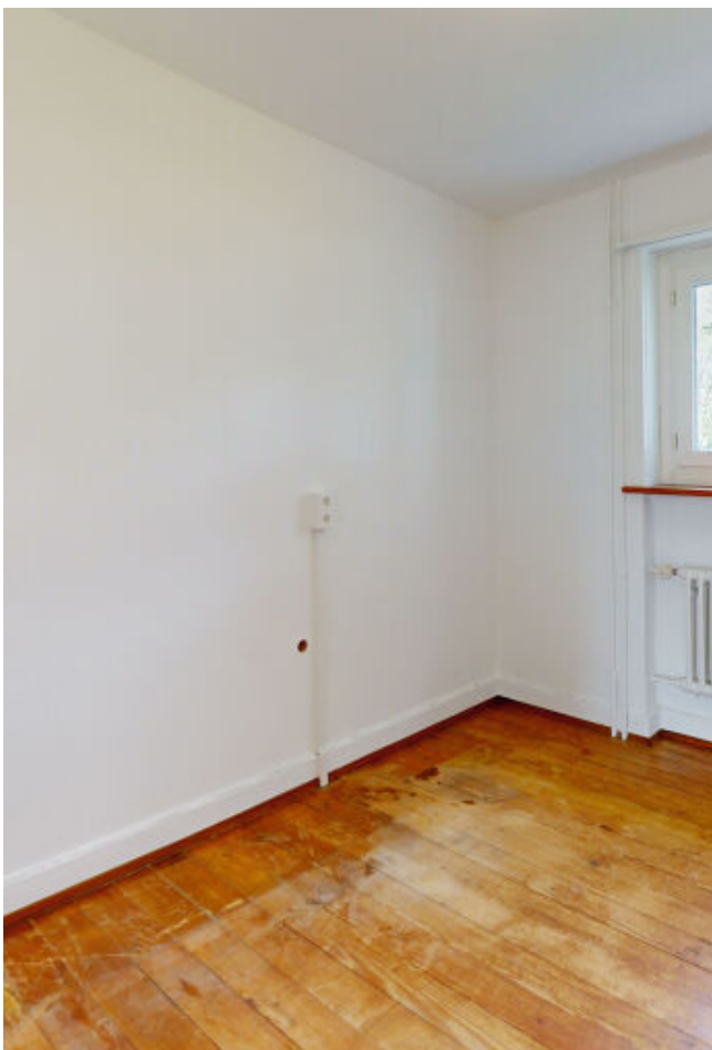
Bereits vorhanden - Ein Durchbruch für den Wasseranschluss
