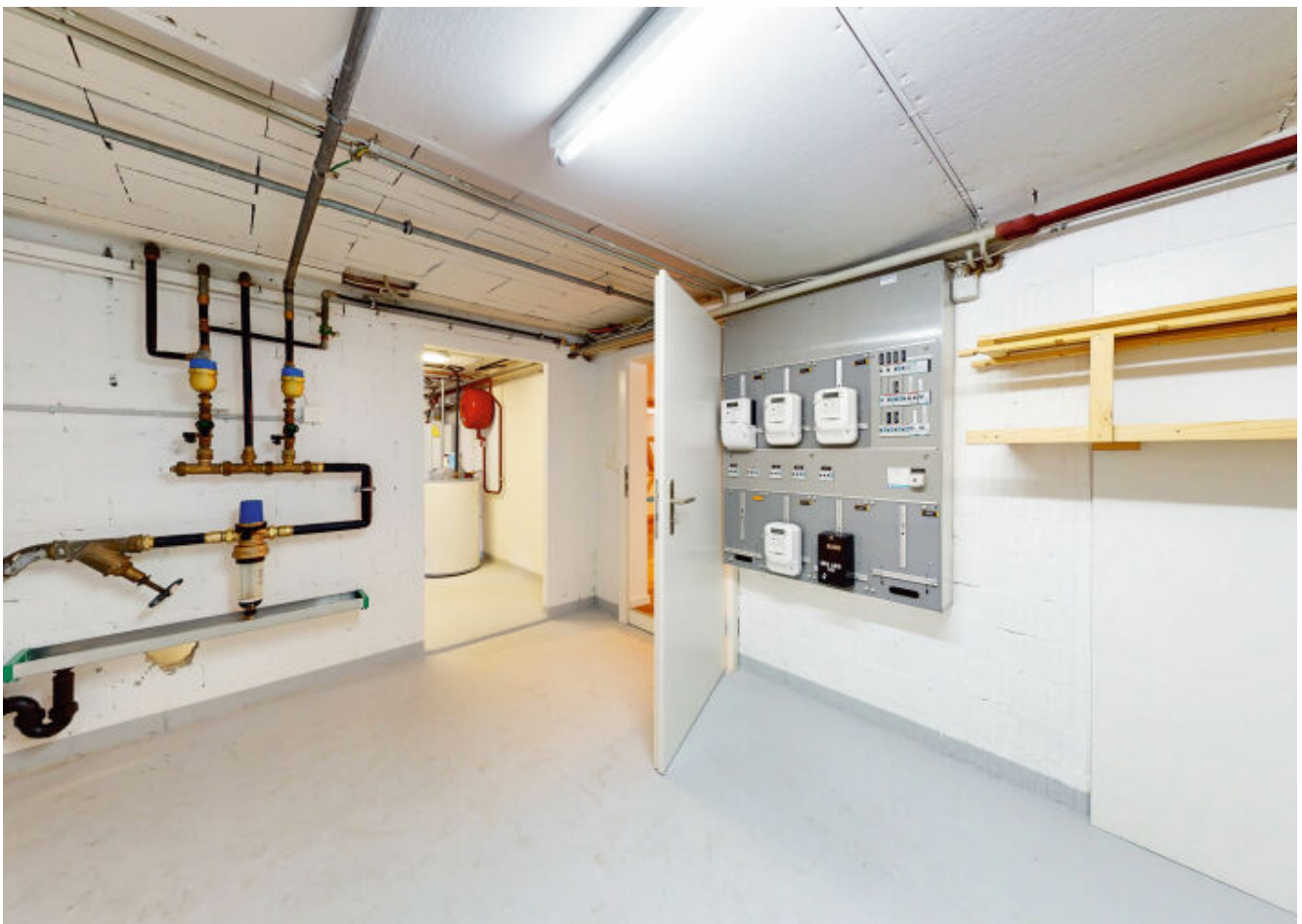
Keller im Untergeschoss.
