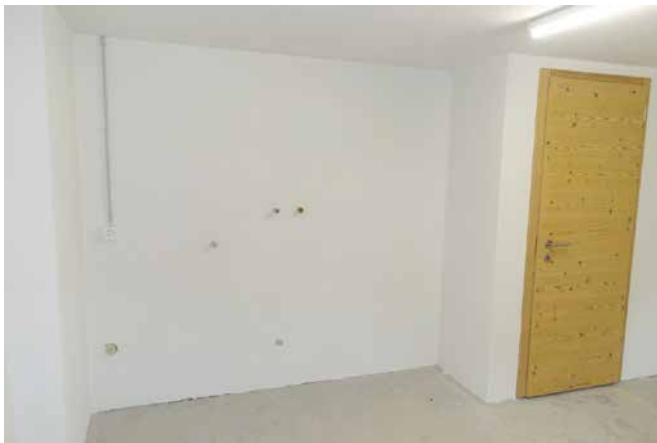
Der grosse Kellerraum ...
