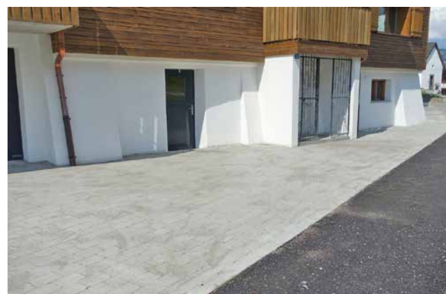
Der Parkplatz der 3½-Zimmer-Wohnung
