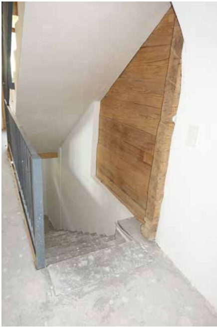
Der Zugang zu den Kellerräumen
