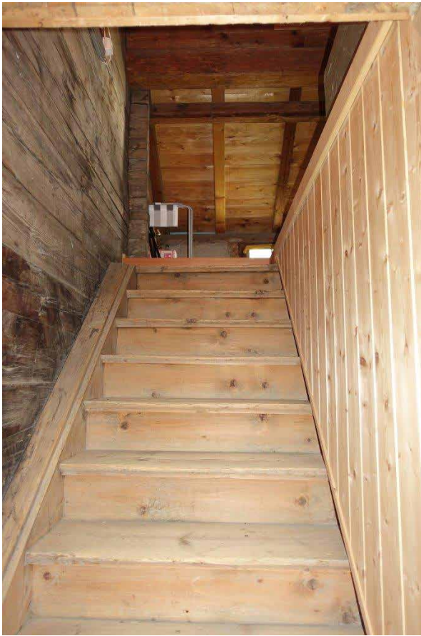
Der Zugang zum Estrich
