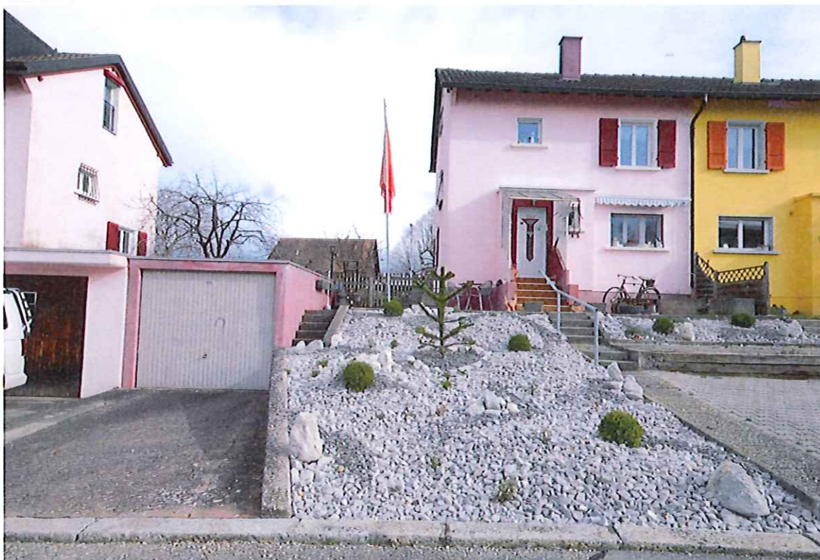
Façade Nord-Ouest avec garage
