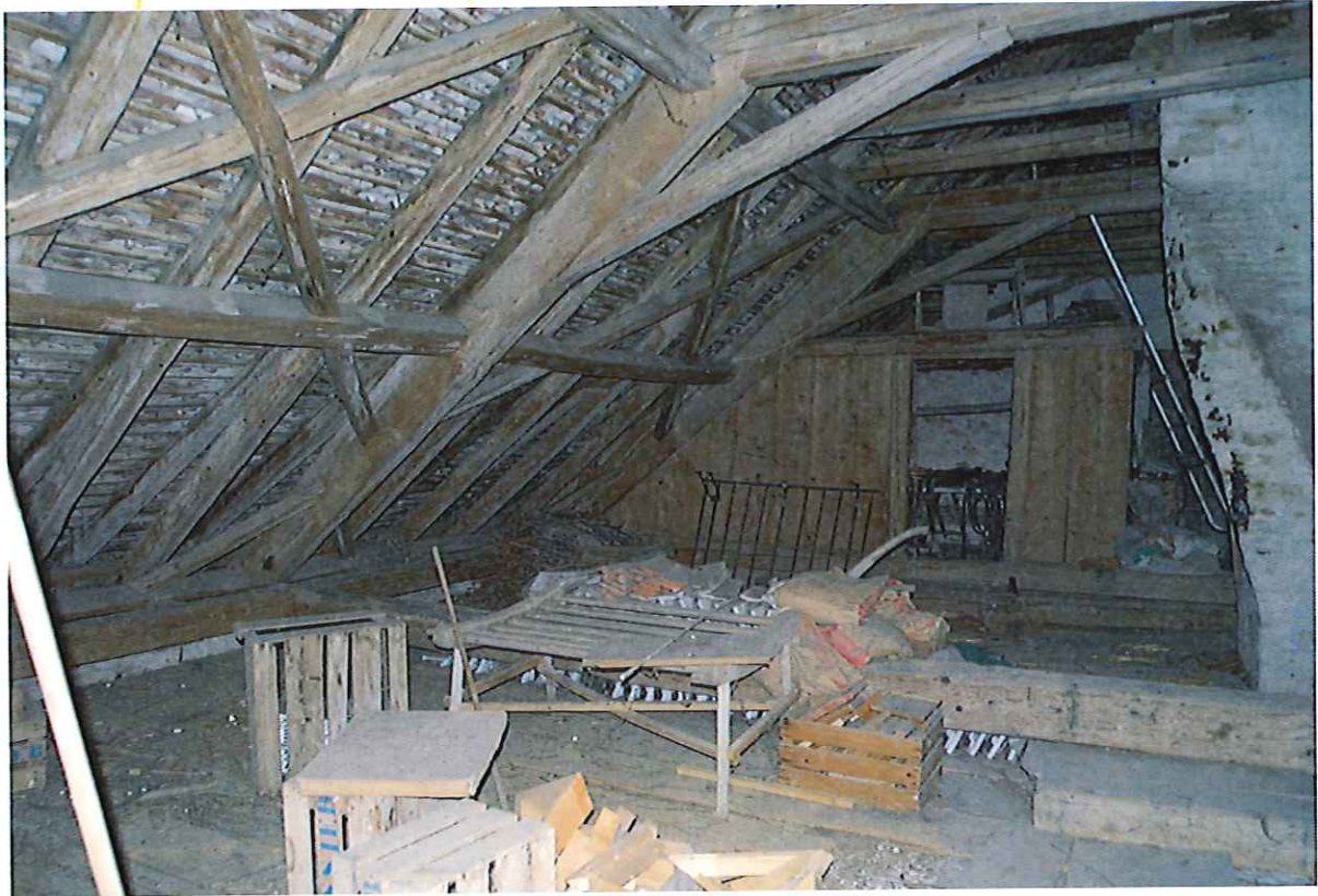
Galets dans les combles
