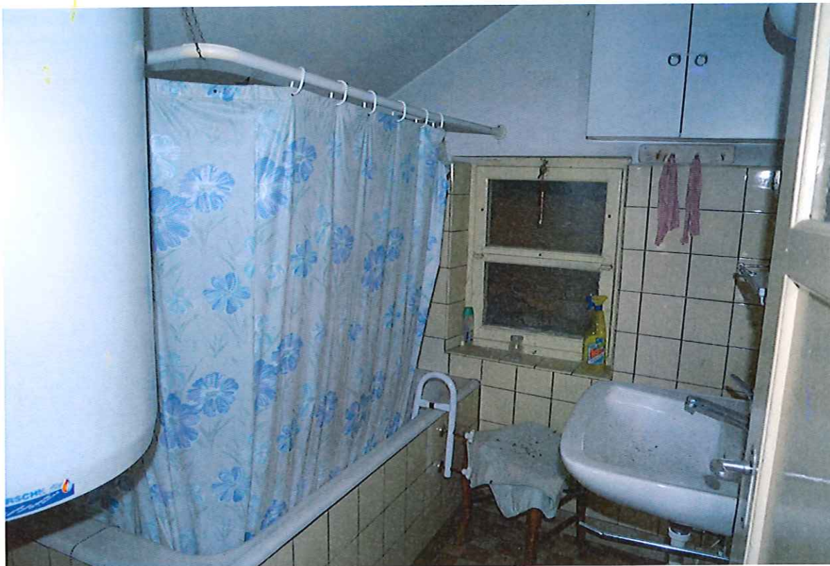
Ancienne salle de bain au rez-de-chaussée
