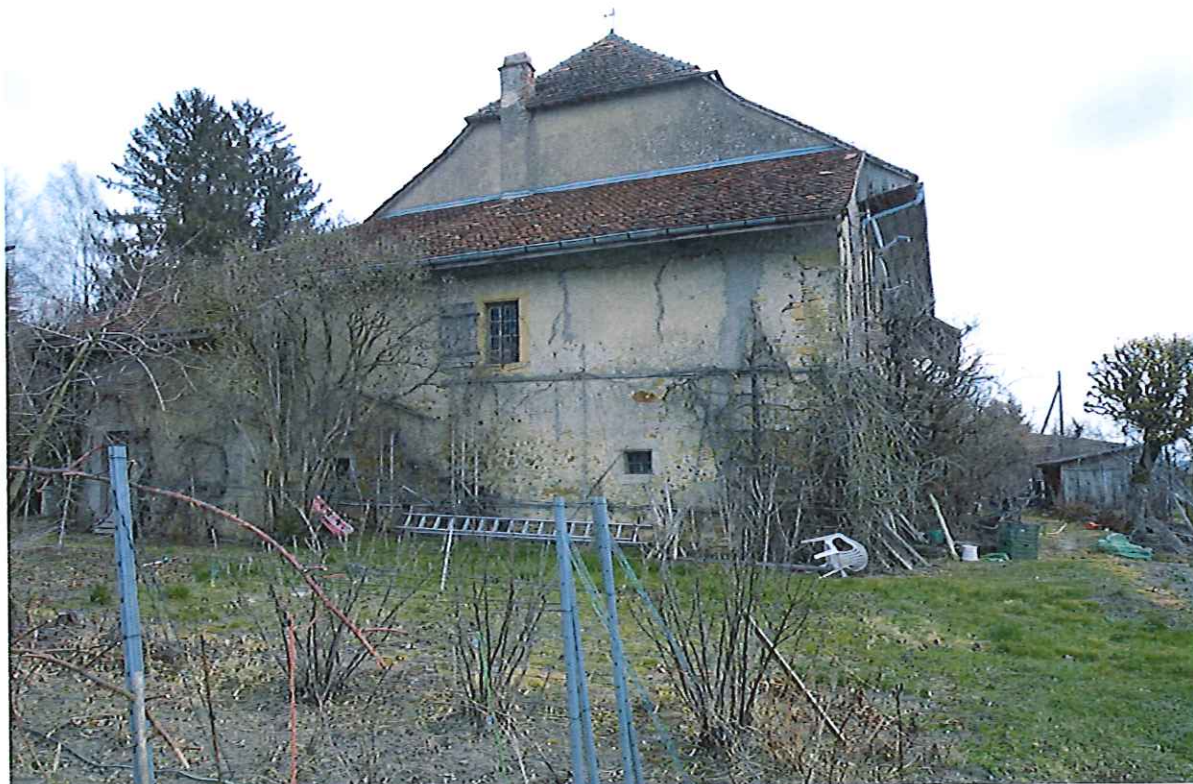
Vue de la façade Ouest
