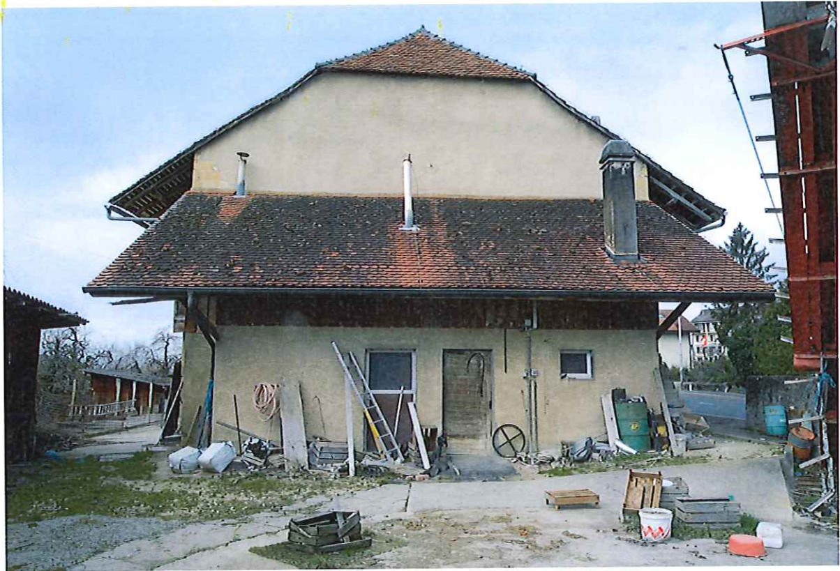
Vue de la façade Est
