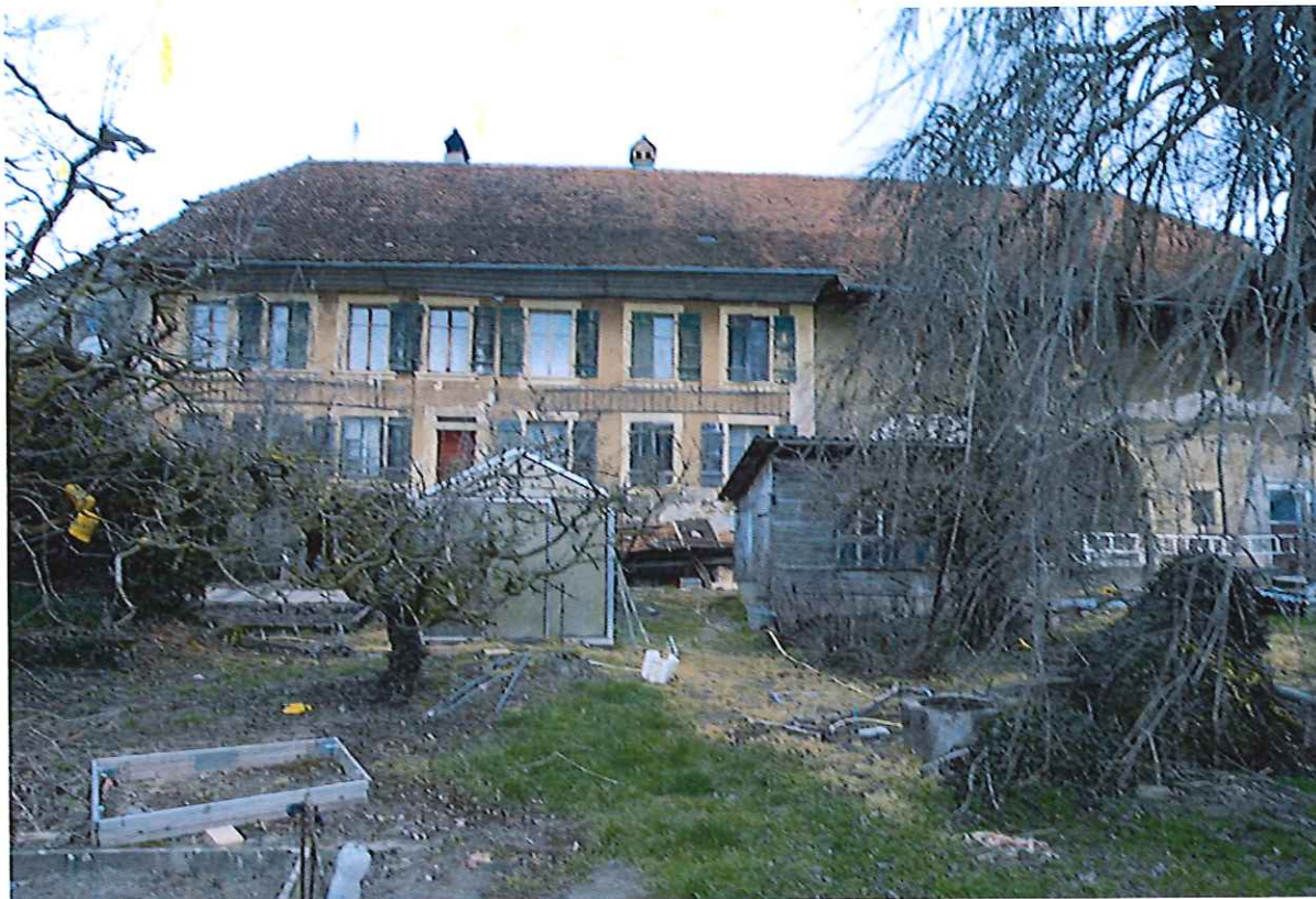
Vue de la façade Sud
