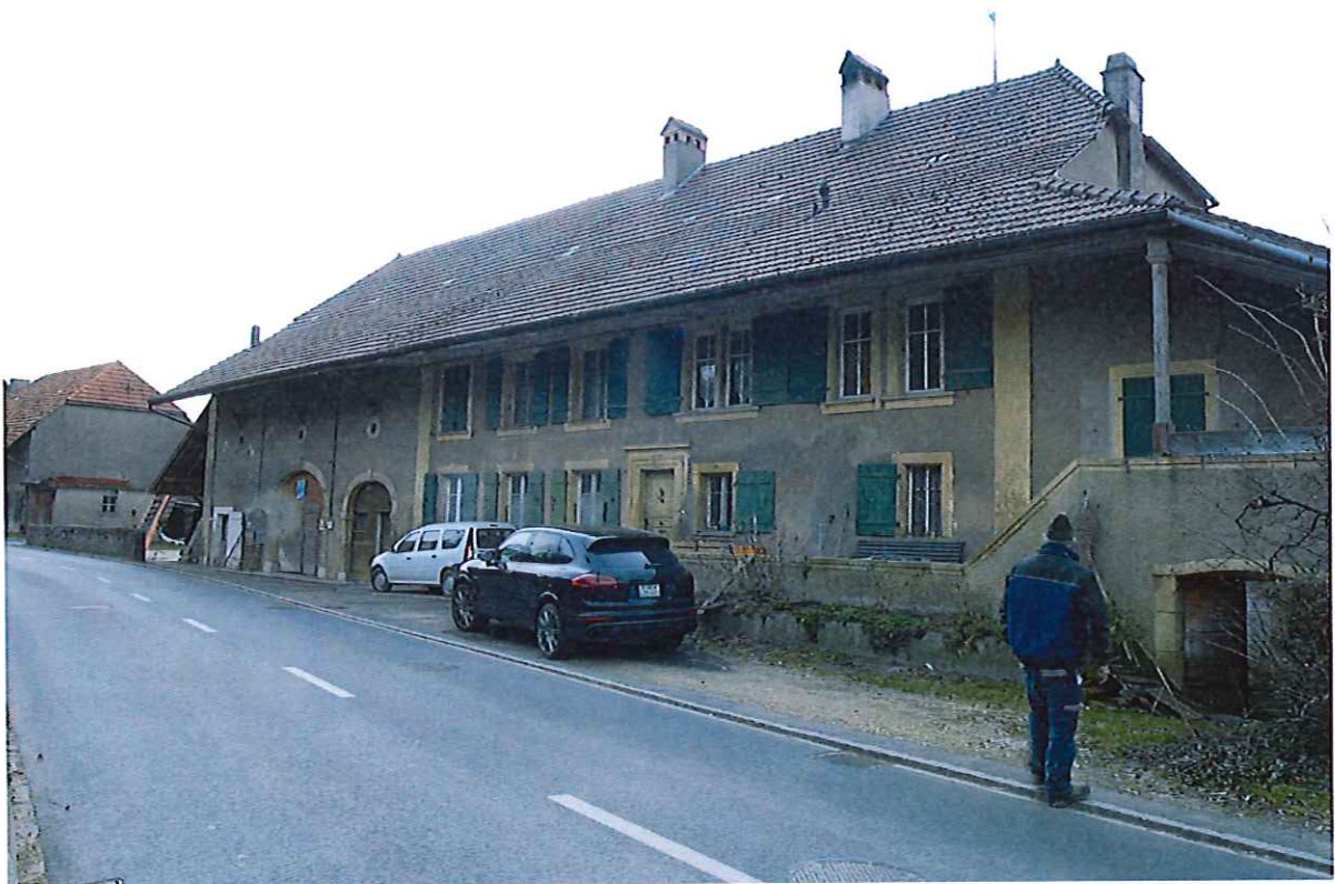
Vue de la façade Nord
