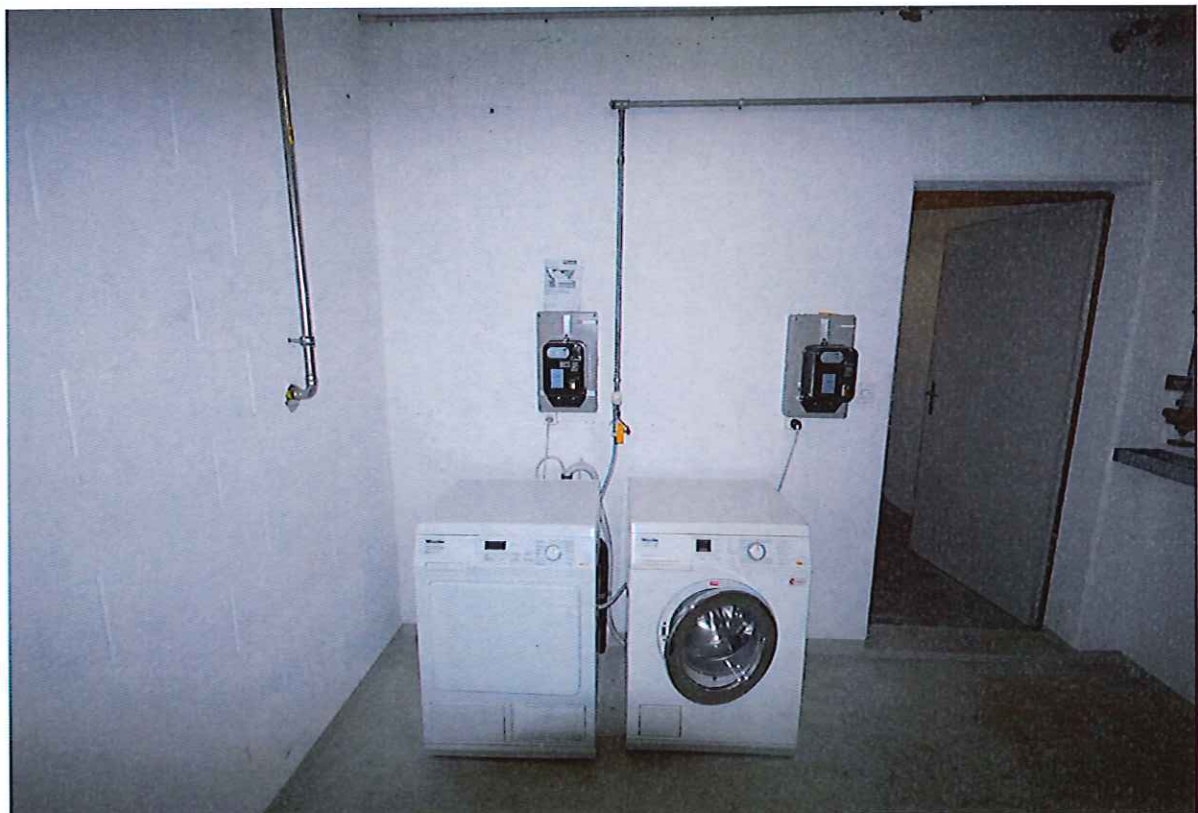
Buanderie commune au sous-sol
