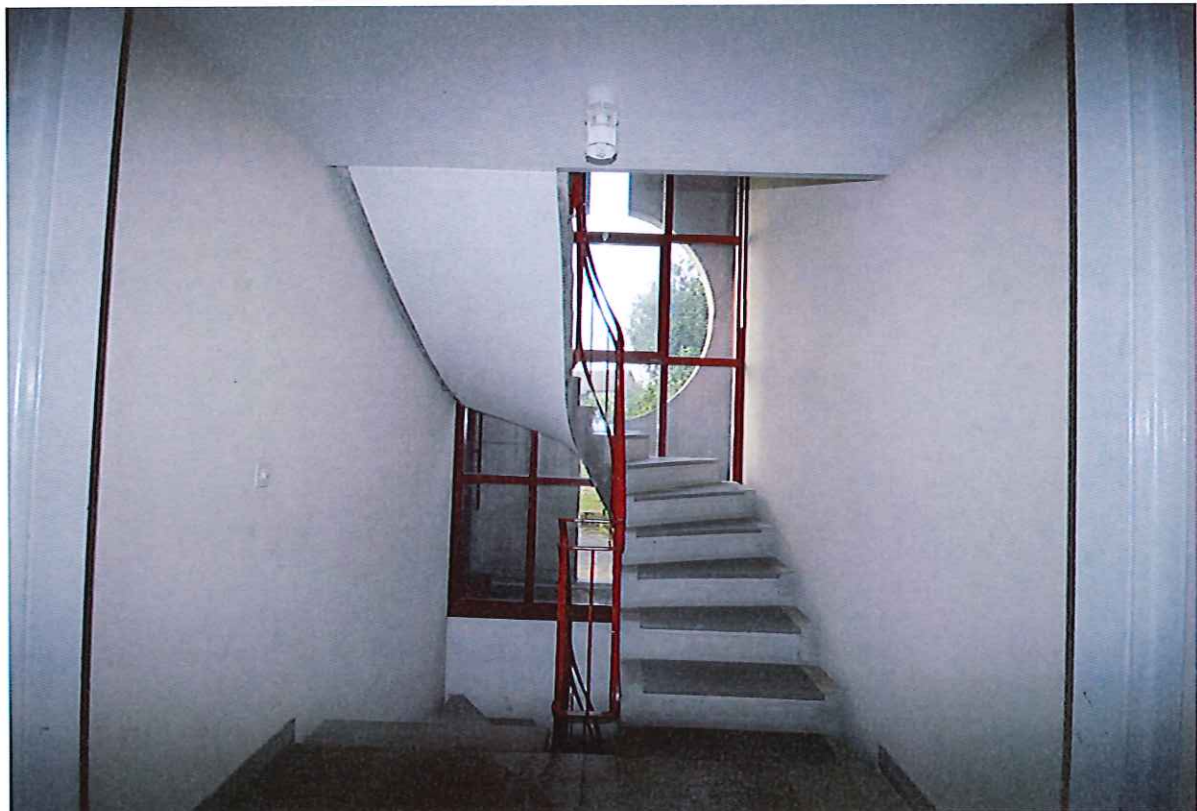
Escalier pour descendre au sous-sol
