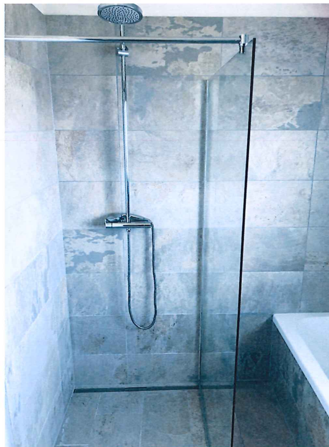
Douche du WC au rez-de-chaussée
