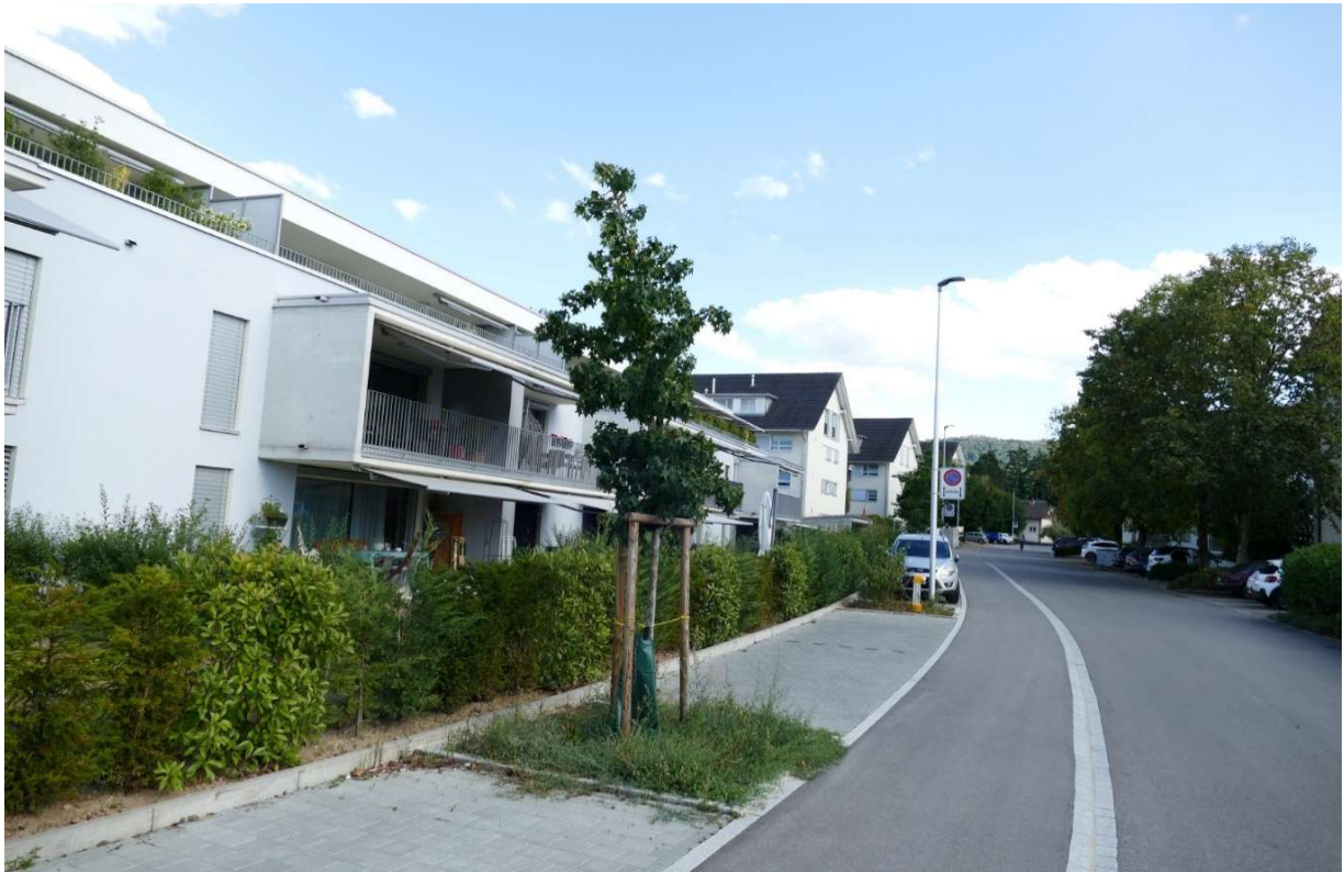
Wohnquartier an der Kirchmattstrasse (mit Besucherparkplätzen)
