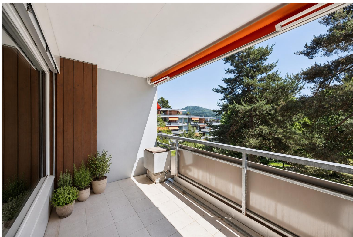
Balkon mit Blick Richtung Gurten und Ulmizberg
