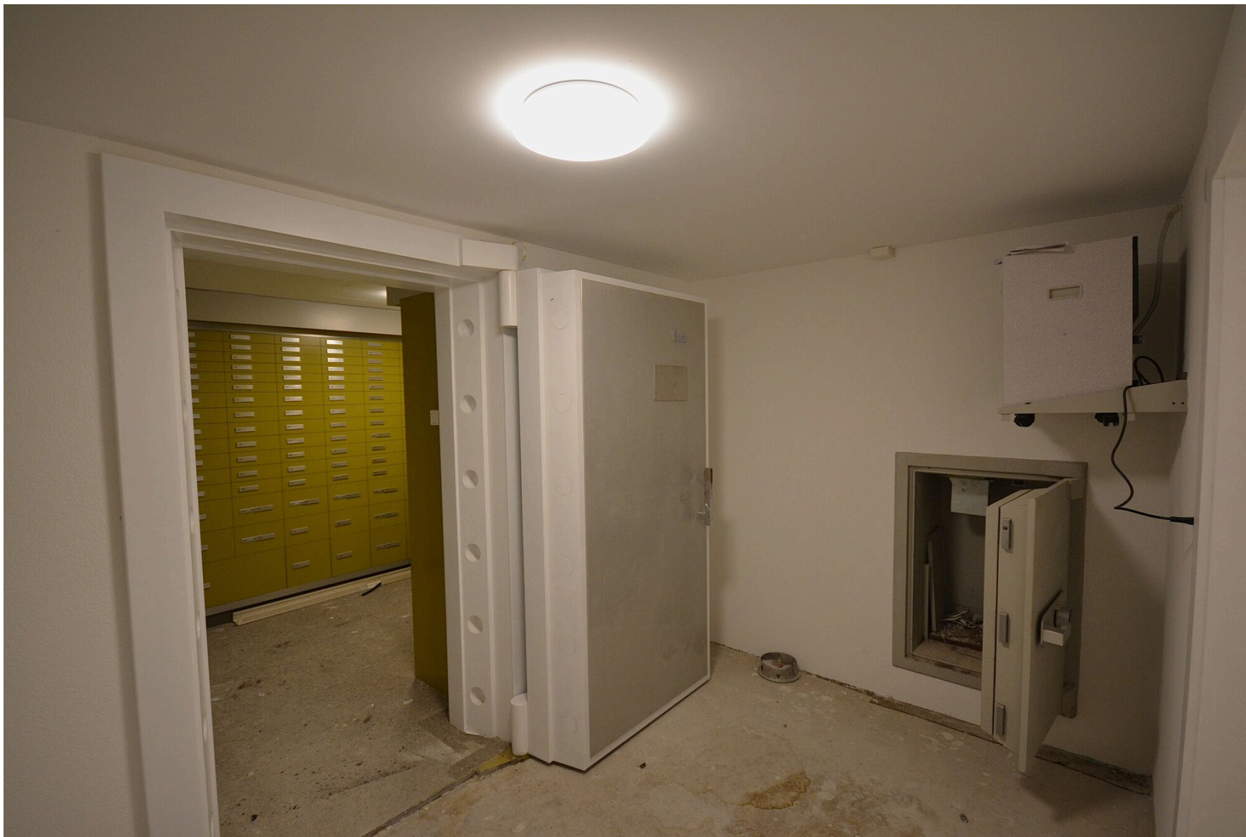
Salle des coffres_s-sol
