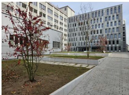
Bau Sektor B
