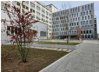
Bau Sektor B
