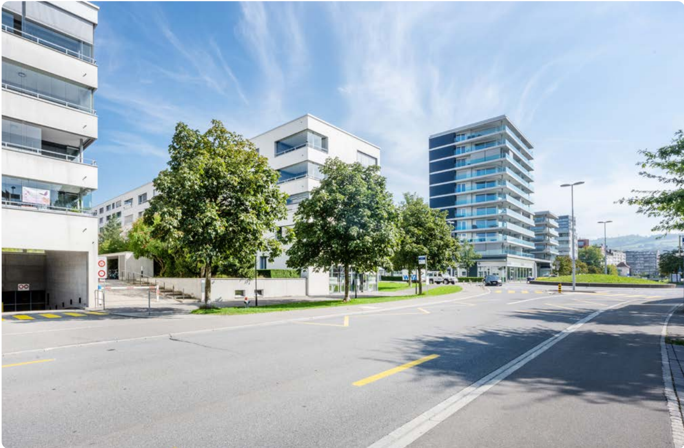
Zufahrtsweg via Feldstrasse
