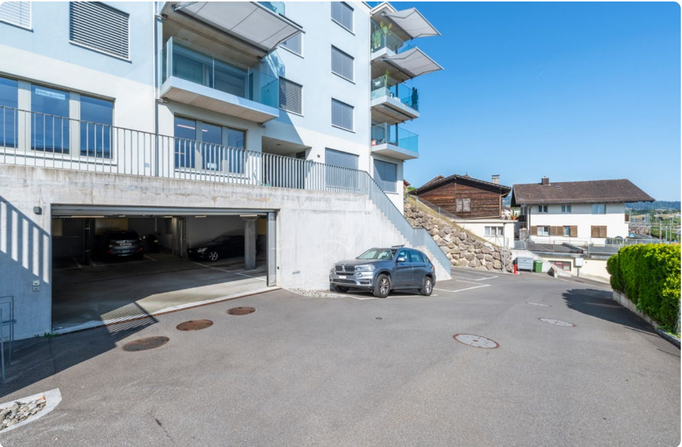
Tiefgaragenzufahrt gleich beim Gebäude
