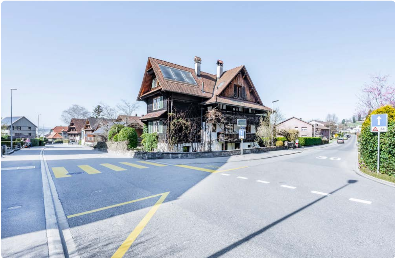
Einfahrt in die Tellenmattstrasse
