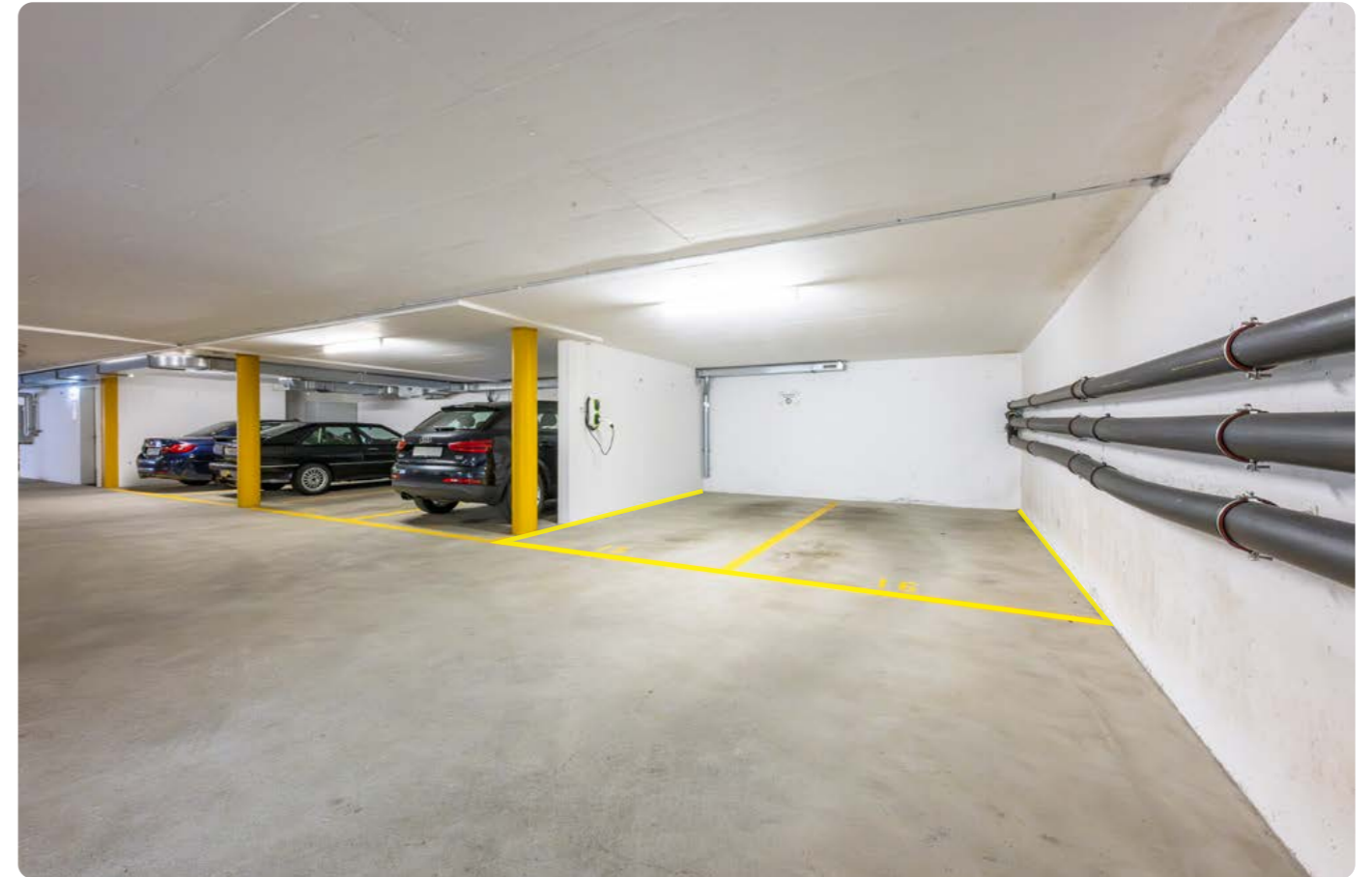
Tiefgaragenparkplätze Nr. 15 + 16 mit E-Auto Ladestation
