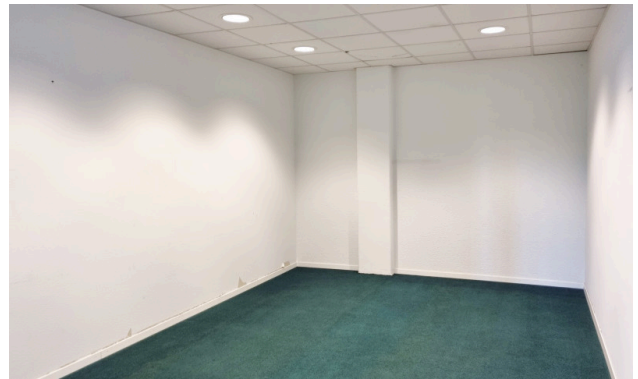
Archiv-/Serverraum mit bestehendem Bodenbelag
