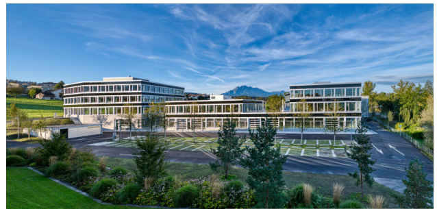
Rückseite der Gebäude 1, 3, 5 mit Pilatusblick
